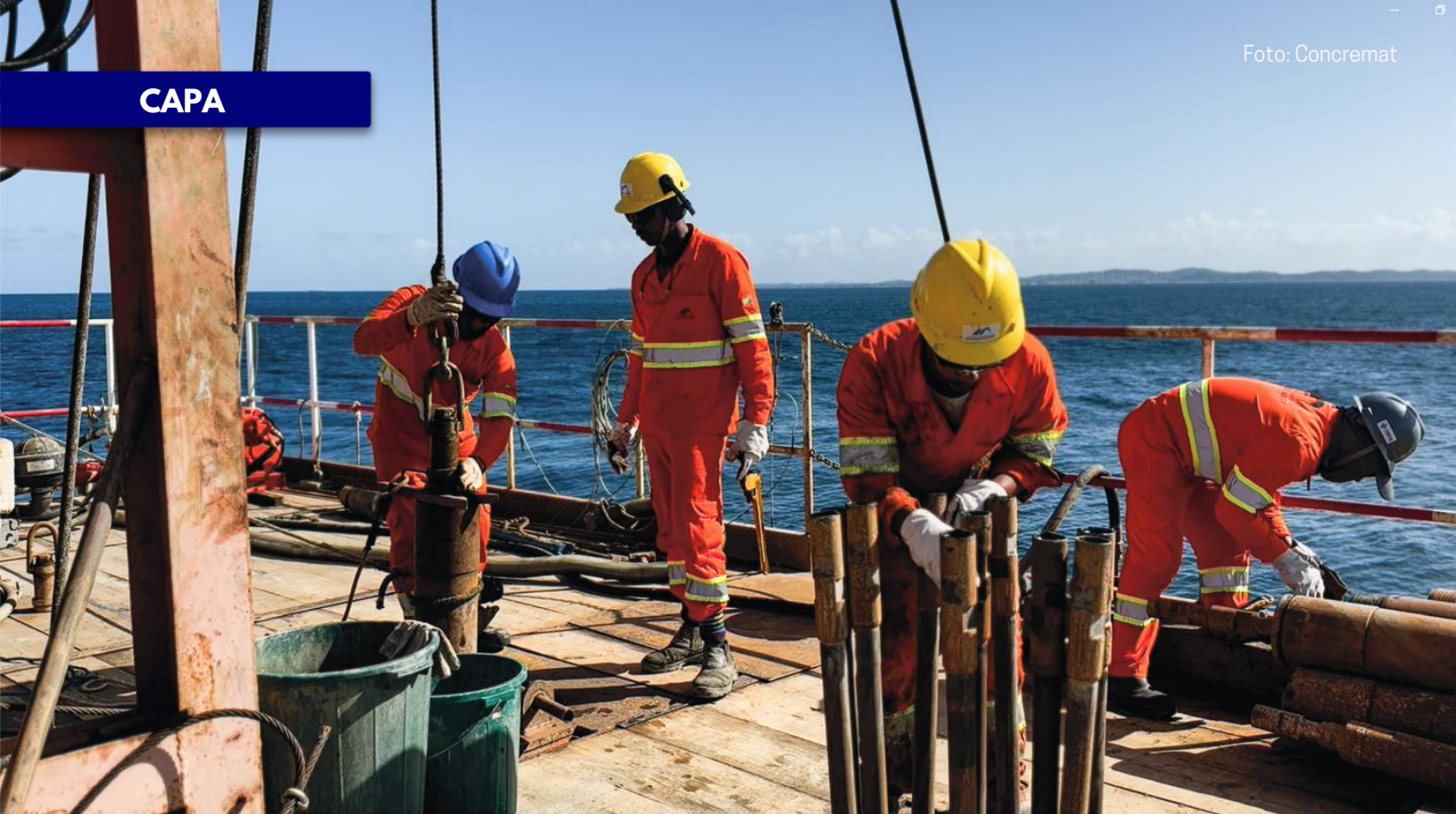
Perfuratriz chinesa sendo operada pelo time CHEC-D com apoio do time Concremat.
