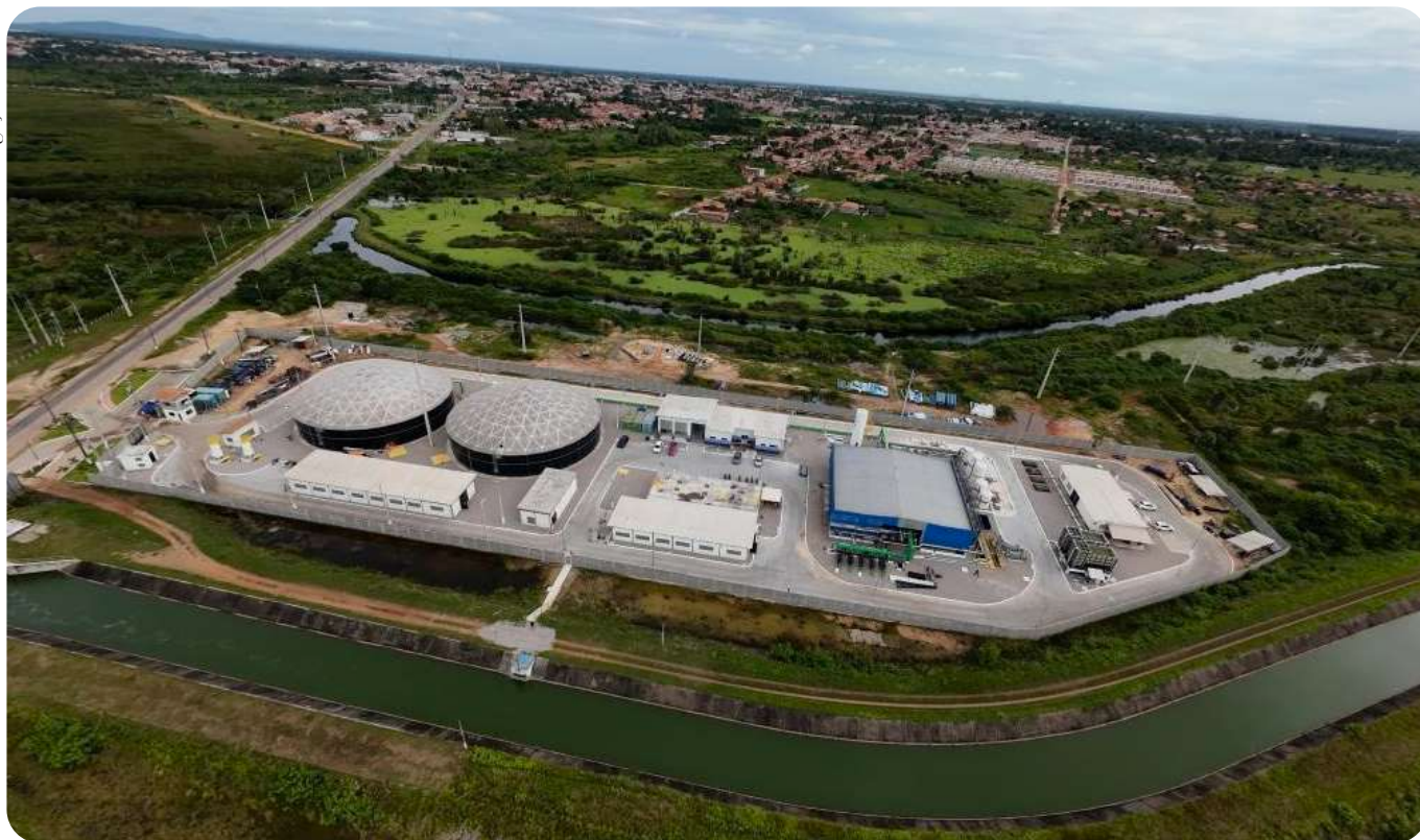
Estação de Tratamento de Águas Pacajus
