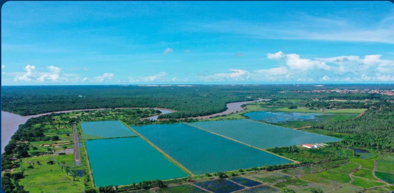
Estação de Tratamento de Esgoto do Município de Parnaíba
