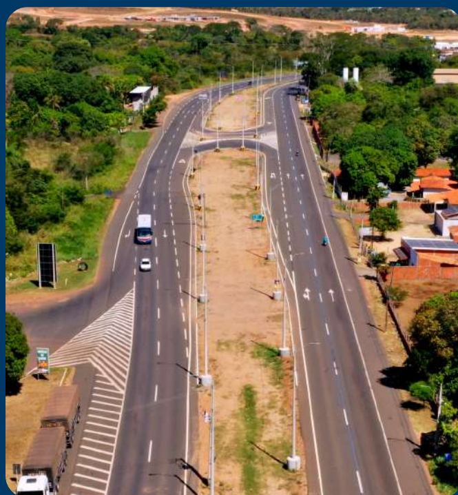
A Jurema foi responsável pelas obras de manutenção da rodovia BR-343/PI
