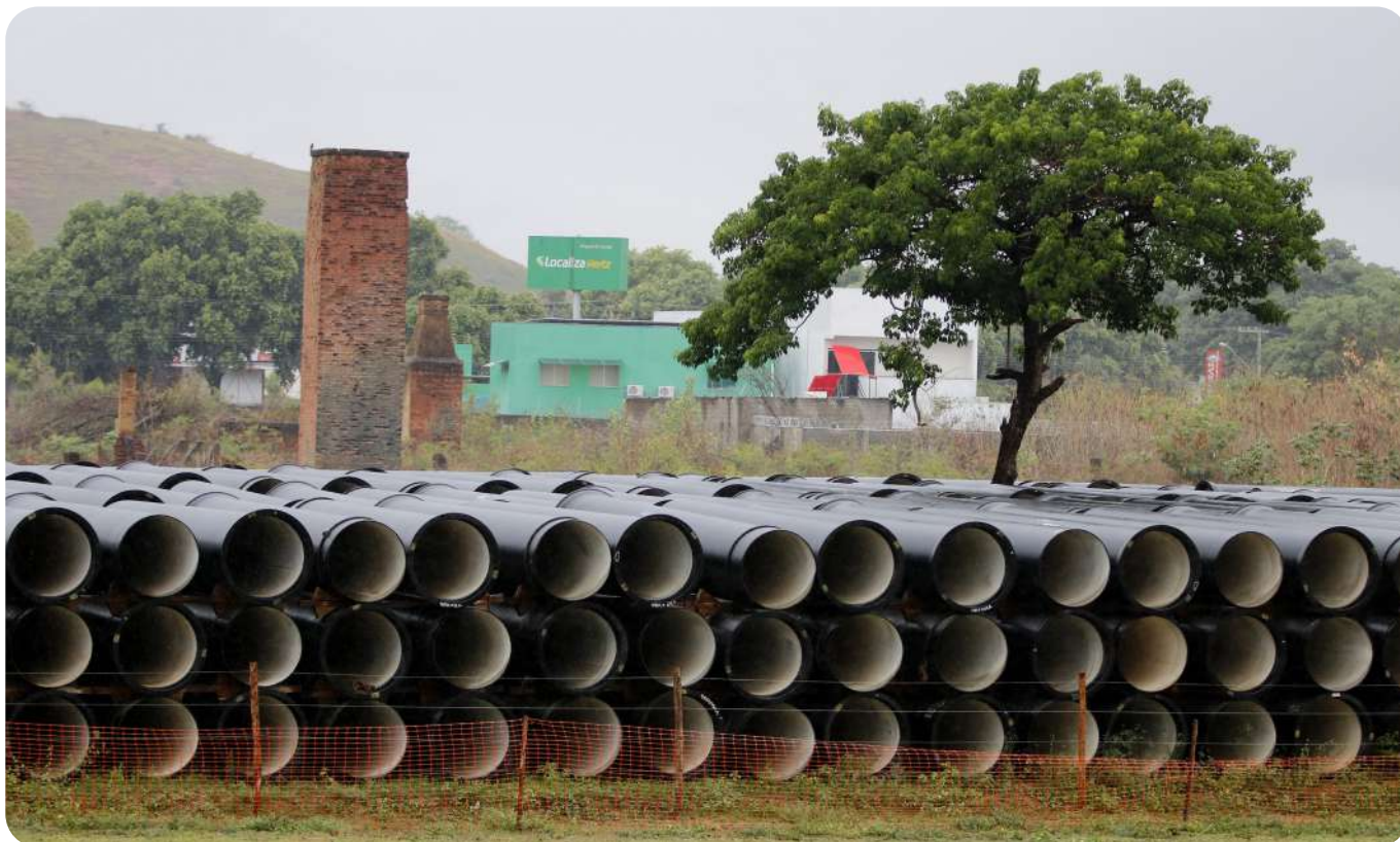
Pátio no perímetro urbano de Governador Valadares, em Minas Gerais, que recebe os tubos que são utilizados em adutora
