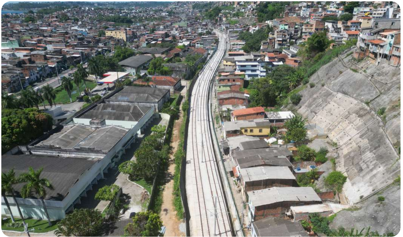
O Lote 1 do VLT de Salvador possui aproximadamente 20 km de extensão
