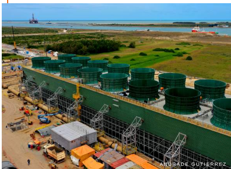
Torre de Resfriamento da Usina Termelétrica GNA I
