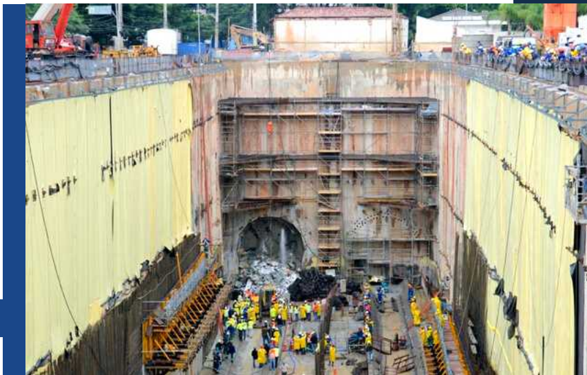
Desemboque do shield na Estação Alto da Boa Vista
