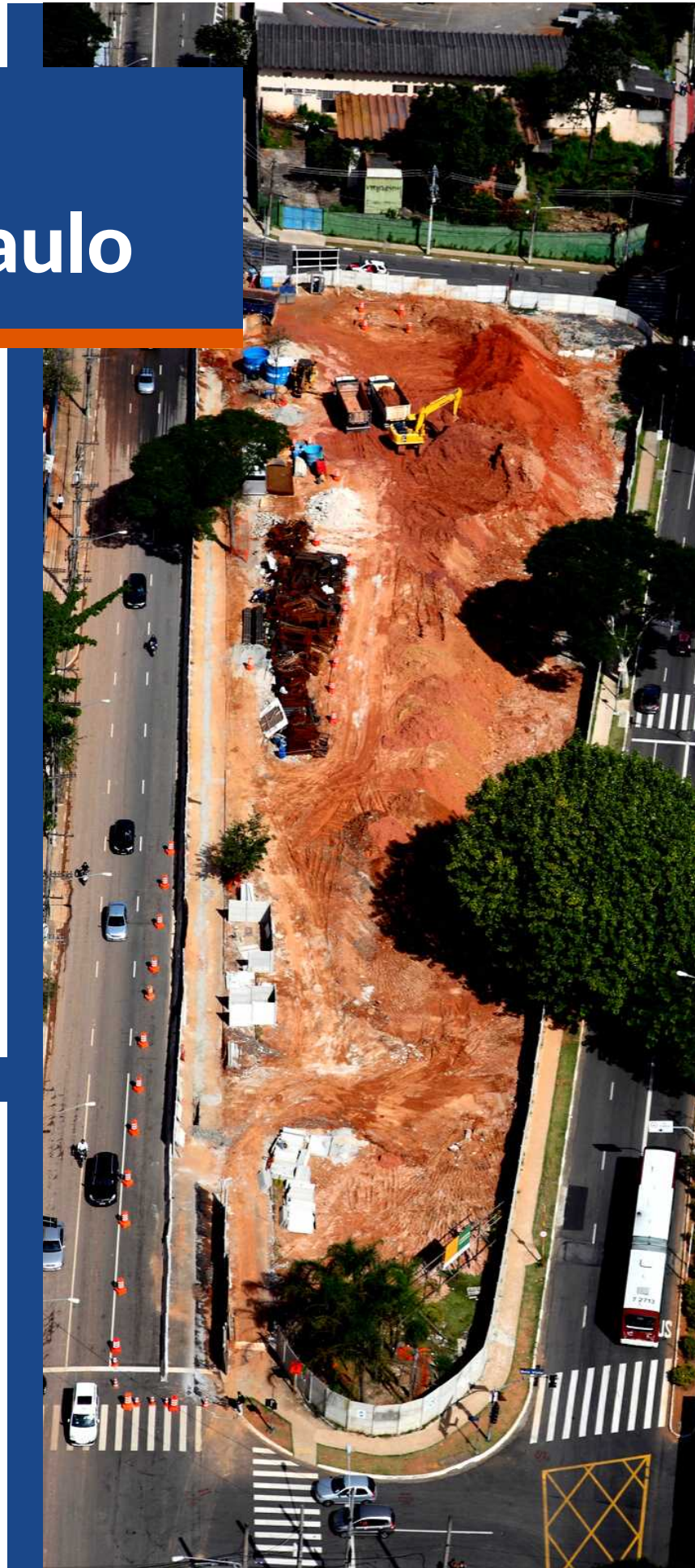
Obras da Estação Borba Gato, confinadas pelas avenidas Santo Amaro e Adolfo Pinheiro
